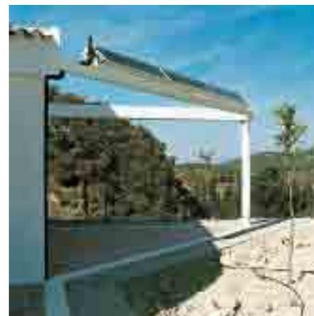
los edificios, que permite aprovechar la inercia térmica del suelo, mejorada por gruesos muros de hormigón, pero también se basa en la utilización de materiales como la cerámica de termo arcilla, que aísla las fachadas. Otro elemento singular en Torre Guil es el aprovechamiento del régimen de vientos.
