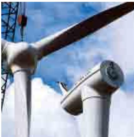
En las dos fotos superiores, fabricación y montaje del NEG Micon 72/2000, de 2 MW y 72 metros de diámetro de rotor, que puede verse a la derecha. Arriba, a la derecha, parque de Vicedo (Lugo), con máquinas de 600 kW de Izar. Esta empresa también comercializa aerogeneradores de 1,3 MW.
