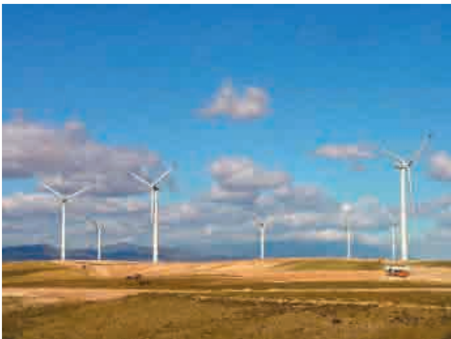
Parque El Águila, situado en el municipio de Pedrola (Zaragoza). Hasta el momento, este es el único parque eólico en España formado por máquinas de la clase megavatio. Son, en concreto, 15 aerogeneradores del modelo N62 de Nordex, de 1,3 MW de potencia unitaria.
