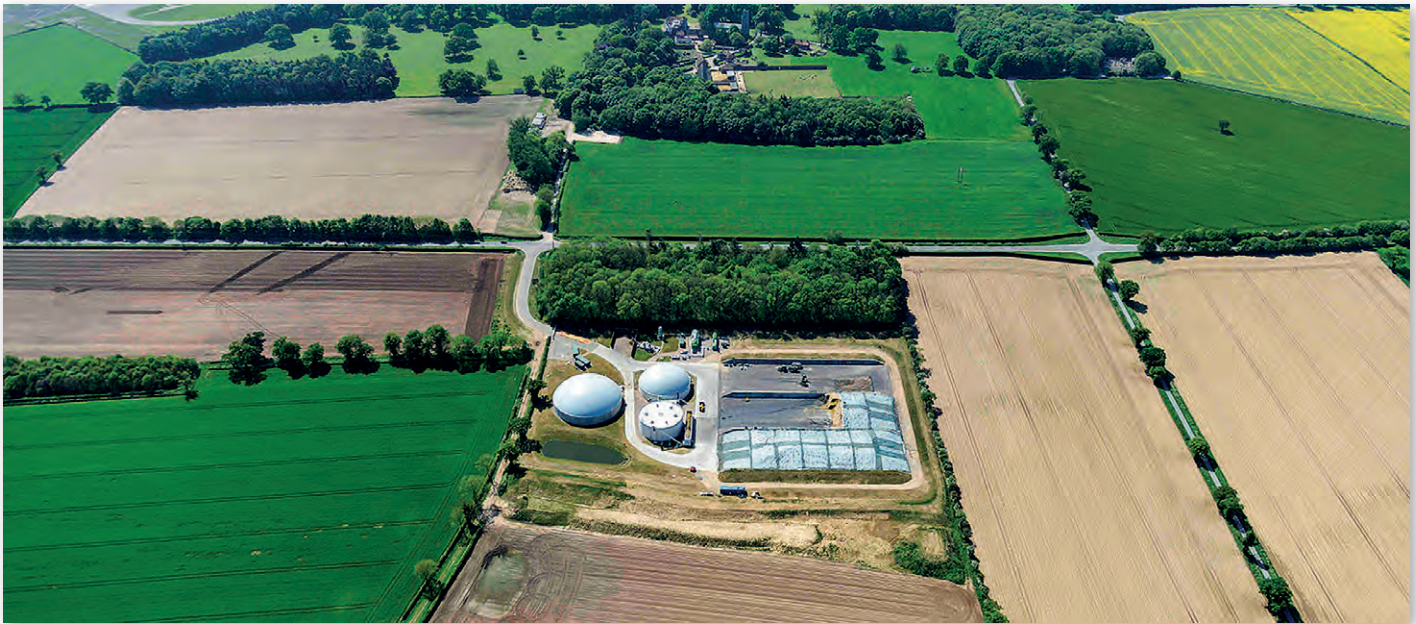
En la página anterior, la planta de biometano de Den Hoorn, en la depuradora de aguas residuales más grande de los Países Bajos. Sobre estas líneas, otra instalación de producción de biogás, en este caso, completamente integrada en el medio rural. Esa integración y la sostenibilidad en el uso de las materias primas son ítems tenidos muy en cuenta en el proyecto Regatrace. Foto: EBA
