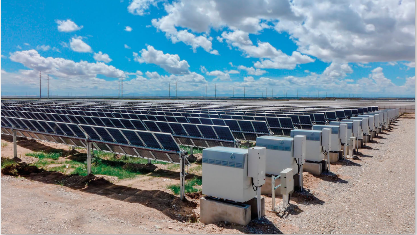
Parque fotovoltaico con baterías de flujo de vanadio de Invinity Energy Systems y esquema de funcionamiento de una batería de flujo redox
