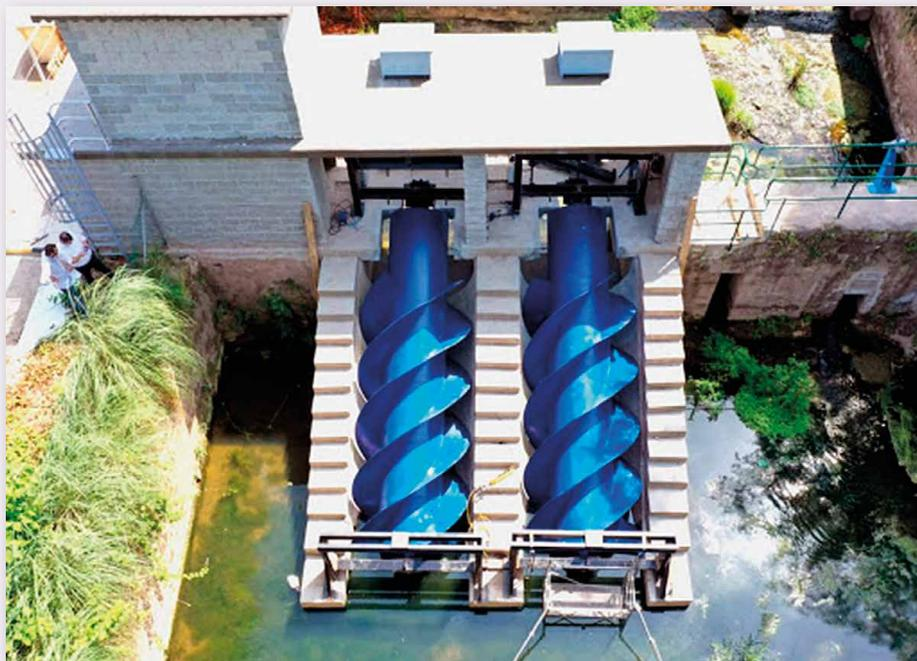
uno. Según la ingeniería responsable de la obra, la central hidráulica Sinfin Barreda, es “la primera instalación de hidrotornillo conectada a red en España”.
