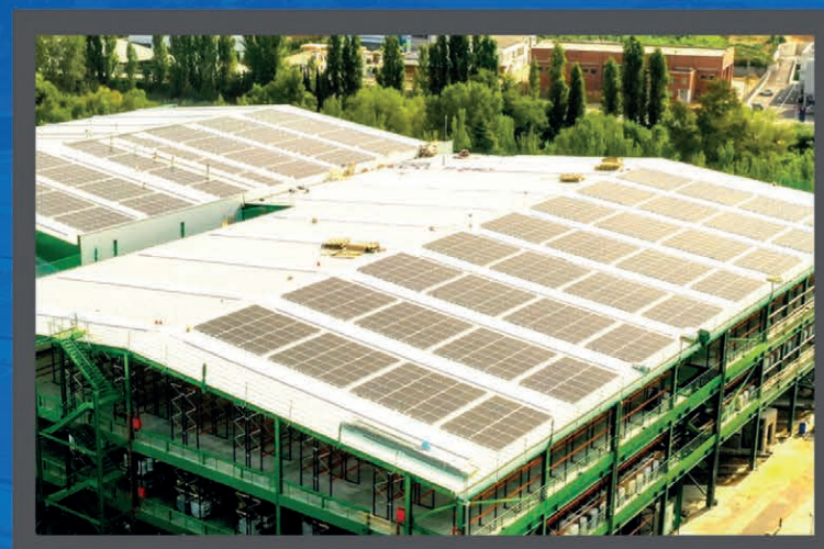
Brugarolas S.A. (Rubí) 422.7KWp
