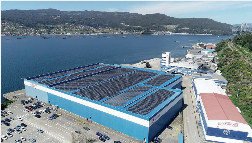
Instalación de autoconsumo, de 927 kilovatios pico, en la factoría del Grupo Nueva Pescanova, en Chapela (Vigo)
