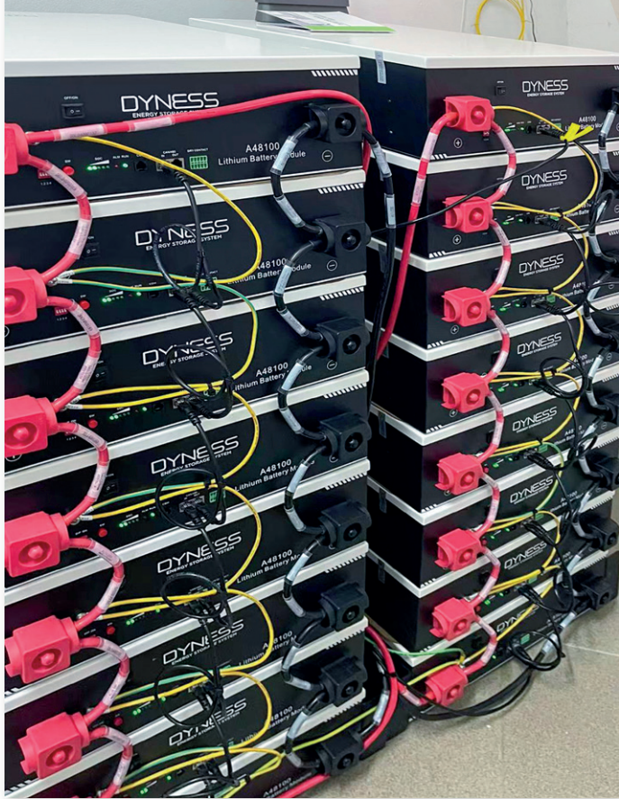
La serie Tower de Dyness tiene un diseño de módulos apilables y adaptables, con cinco opciones de energía que van desde 7,10 kWh hasta 21,31 kWh
